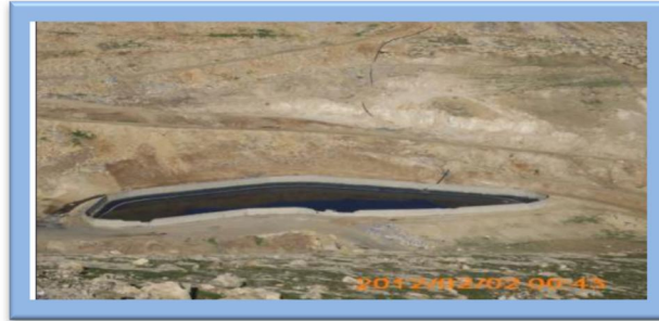
صورة رقم (٤) توضح احد سدود حصاد المياه / وادي النار. (١٢)
